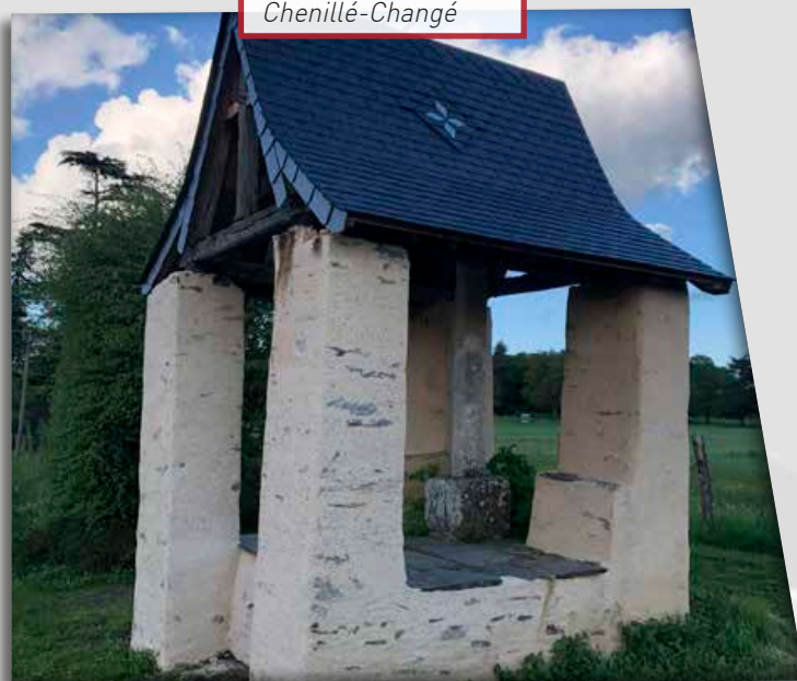
Finalisation des travaux de l'oratoire de la Blinière de Chenillé-Changé
