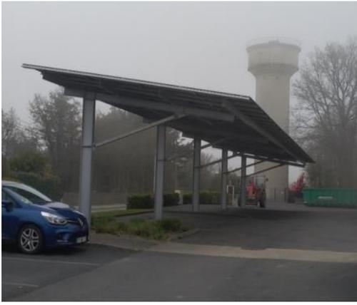
Les travaux des ombrières sur le parking de la salle de sport sont presque terminés ! La puissance globale finale sera de 45 kWc ; ce qui permet une production d'électricité estimée à **53,8 MWh/an**.
