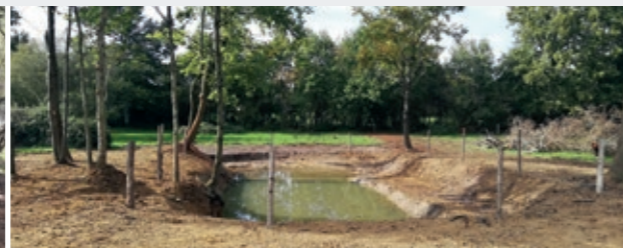
Un avant-après d'une mare bocagère suite aux travaux de restauration
