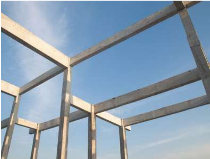
Principe de préfabrication porteuse Béton
