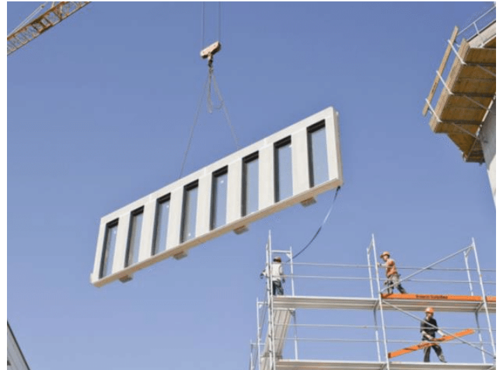
Principe de préfabrication de façade
