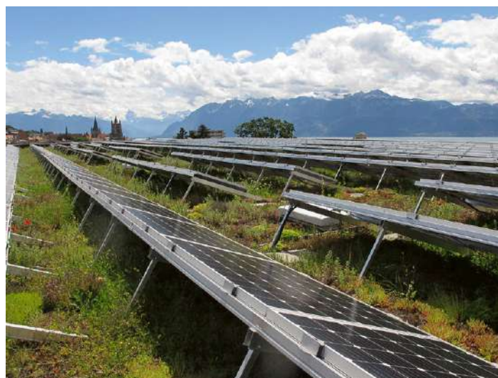
Toiture biosolaire (couplant panneaux photovoltaïques et végétalisation)
