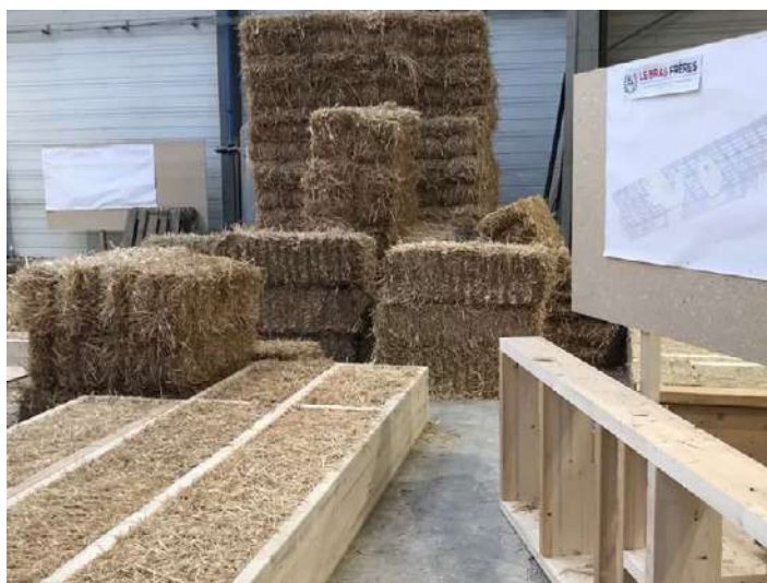
Principe d'un caisson bois-paille
