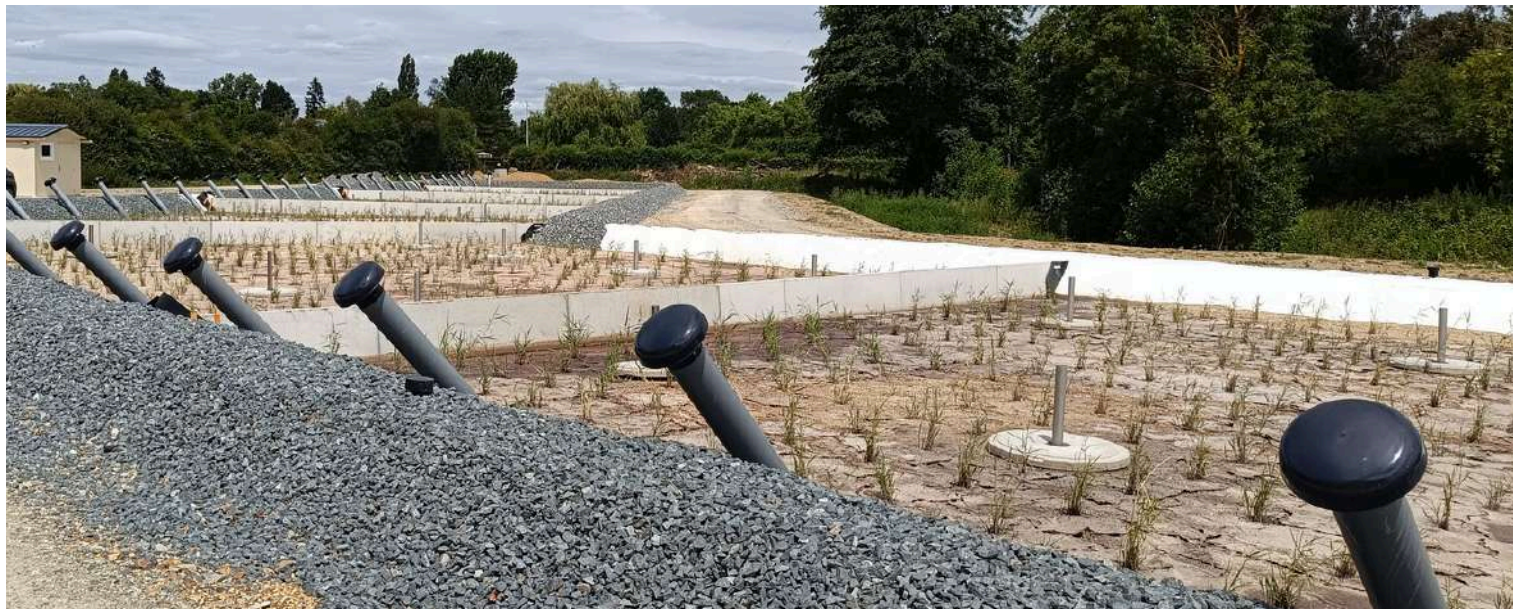
Nouvelle station d'épuration en cours de réalisation
